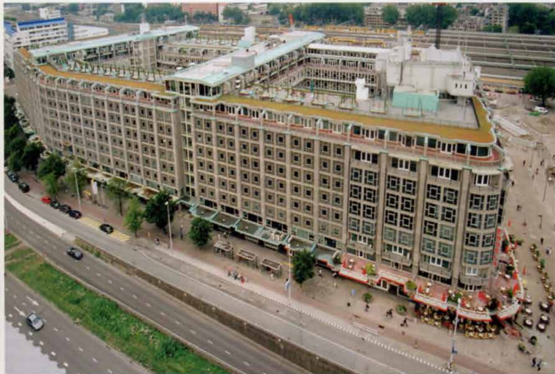
1 | Groot Handelsgebouw na renovatie (foto's Architectenbureau J. van Stigt)
