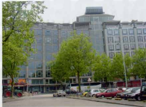
4 | Tijdens de renovatie: het linkerdeel is al bewerkt, terwijl het beton rechts nog verborgen is onder lagen witte verf
