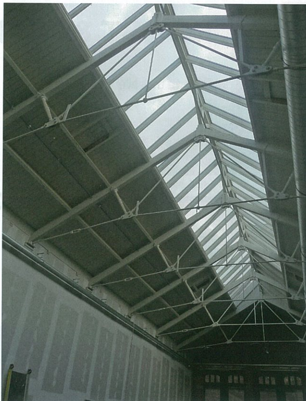
De Polonceau-spanten tonen het industriële karakter van de grote hallen.
