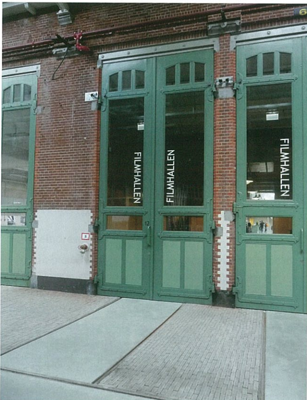
De 5,5 meter hoge deuren en de tramrails zijn behouden gebleven. Hierdoor reden de trams de hal in.
