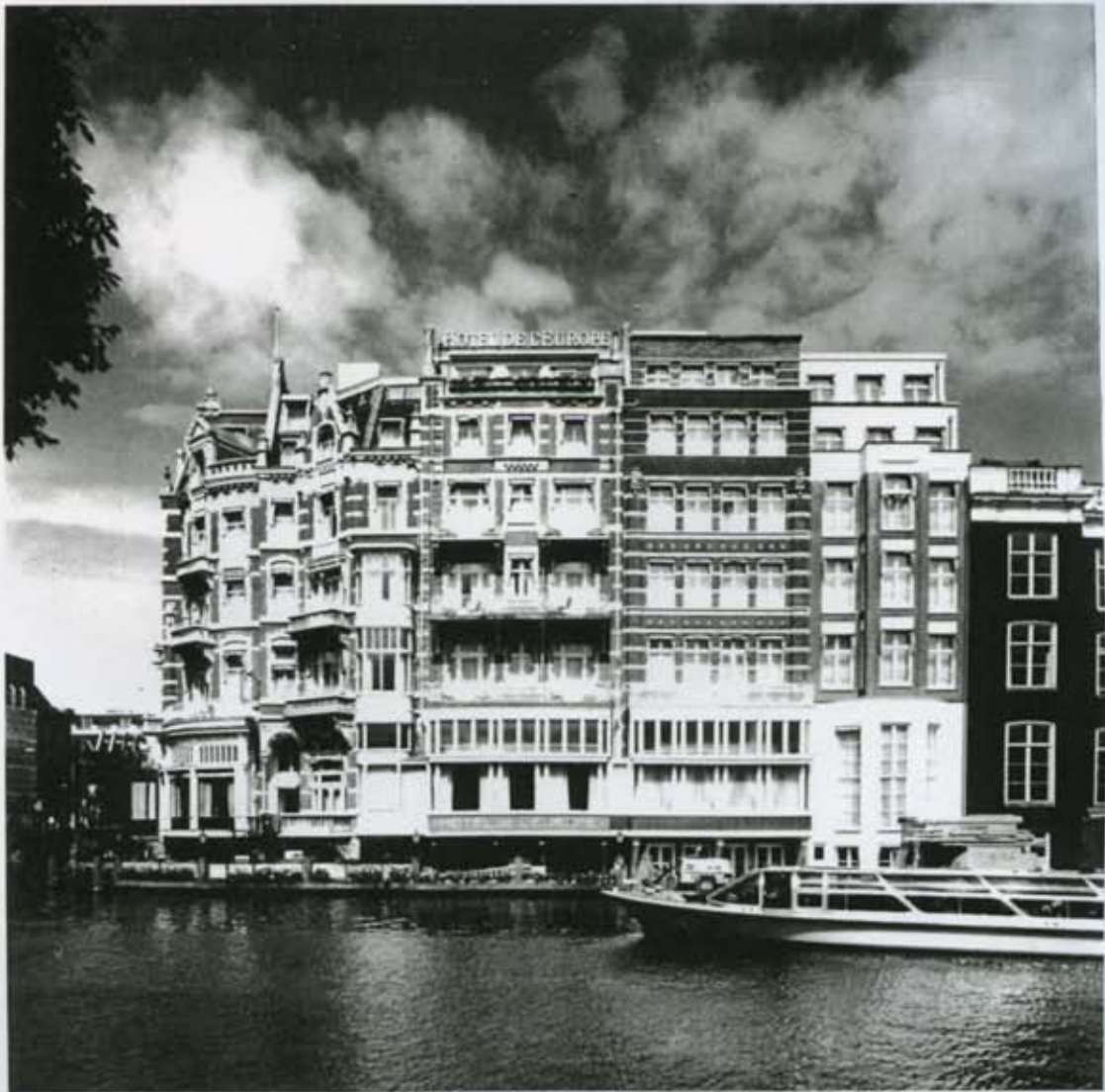
De achterzijde van Hotel de l'Europe in de bocht van de Amstel. In 1987 werd het hotel met twee belendende percelen uitgebreid. De glazen uitbouw die de Gebr. Van Gendt in 1911 hadden aangebracht is bij het pand ernaast identiek bijgebouwd.
