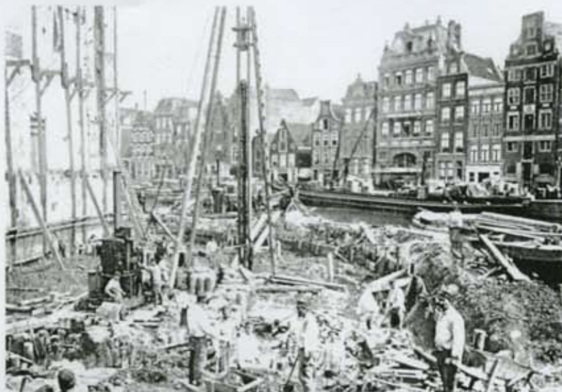
Het heien van de eerste paal voor Hotel de l'Europe, 1895, uit Het Rondeel herdacht 1481-1896.
