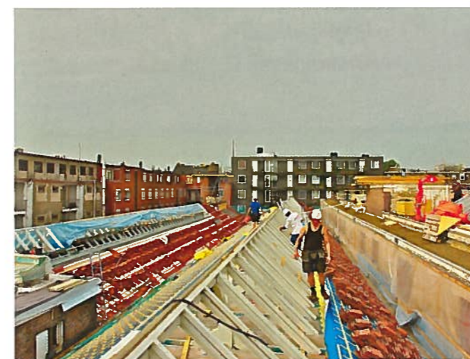
In het kader van herbestemming van een meer dan een eeuw oude tramremise aan het Bellamyplein in Amsterdam Oud-West zijn zo'n 15.000 m 2 dak en meer dan 2 kilometer lichtstraat gerenoveerd. Multifunctioneel centrum De Hallen vond er onderdak.
