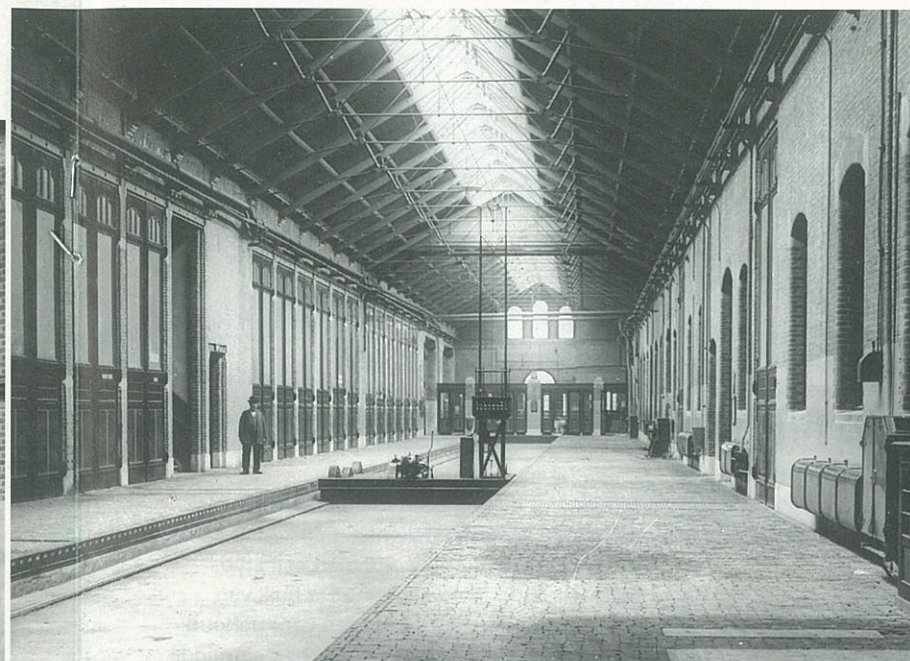
Een van de hallen met Polonceau-spanten. Ongedateerde opname.
