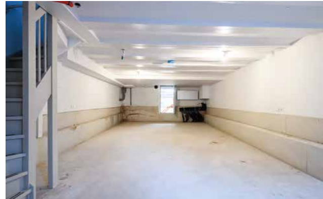
De kelderverdieping met nieuwe betonnen kelderbak.
