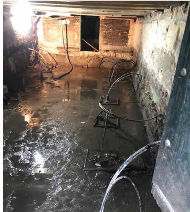
In de nieuwe kelderbak zijn 19 Groene Palen aangebracht.
