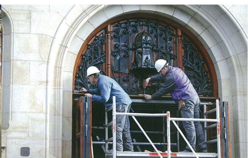
Gevelrestauratie betreft metselwerk, natuursteen, ornamenten en kozijnen.
