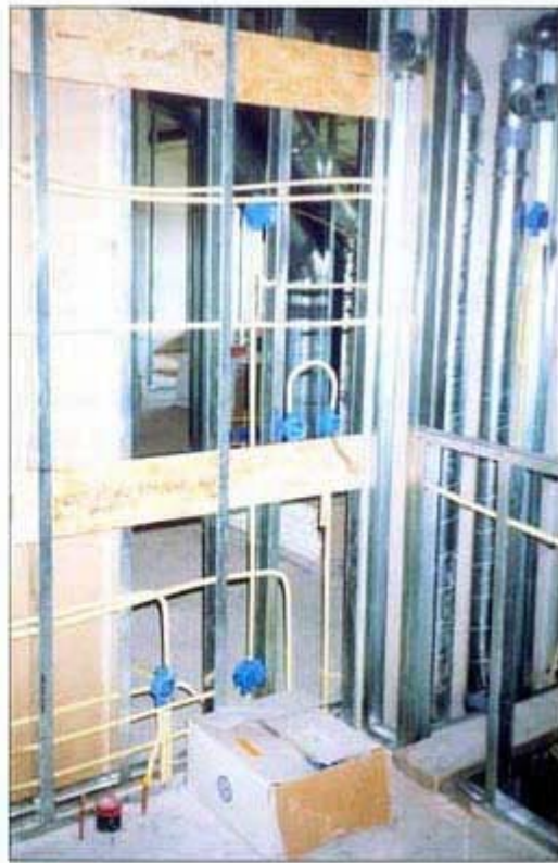
Het "skelet" waartegen de platen worden bevestigd. Ontluchtingskokers en electra worden weggewerkt achter de platen.
