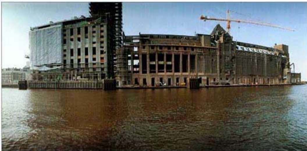
Een overzicht van de Silodam. Foto is genomen vanaf het IJ. Je kunt de stroken die uitgezaagd zijn zo mooi zien. (foto: Ernest Annyas Fotografie).
