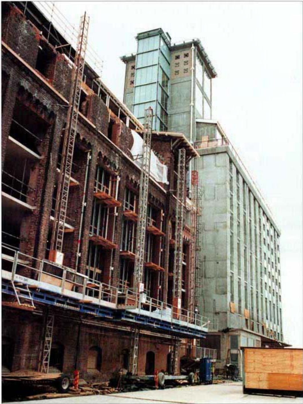
Op dit moment wordt hard gewerkt aan de stenen silo. Het houten hokje op de voorgrond is een "lifthusje".
