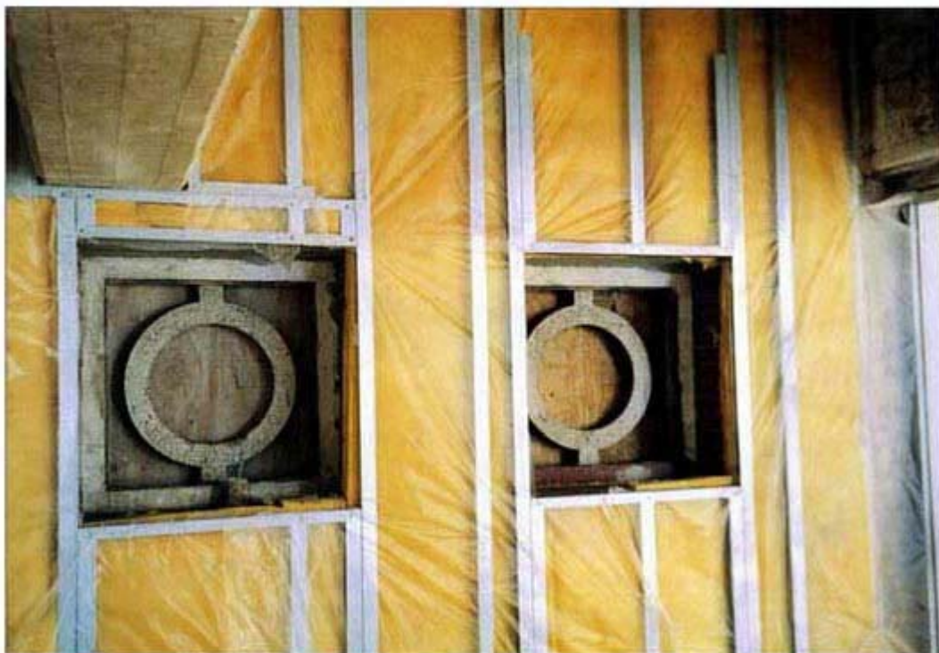
Deze wand is klaar om gipsplaten tegenaan te plaatsen
